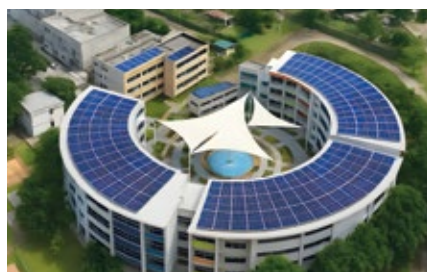
PANELES SOLARES Y ALM. ENERGÍA
