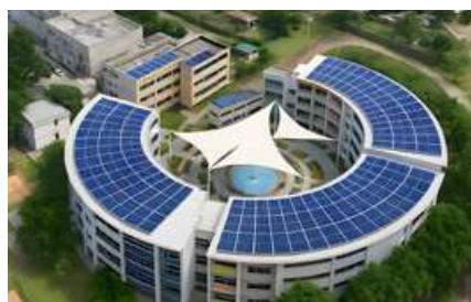
PANELES SOLARES Y ALM. ENERGÍA
