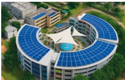
PANELES SOLARES Y ALM. ENERGÍA
